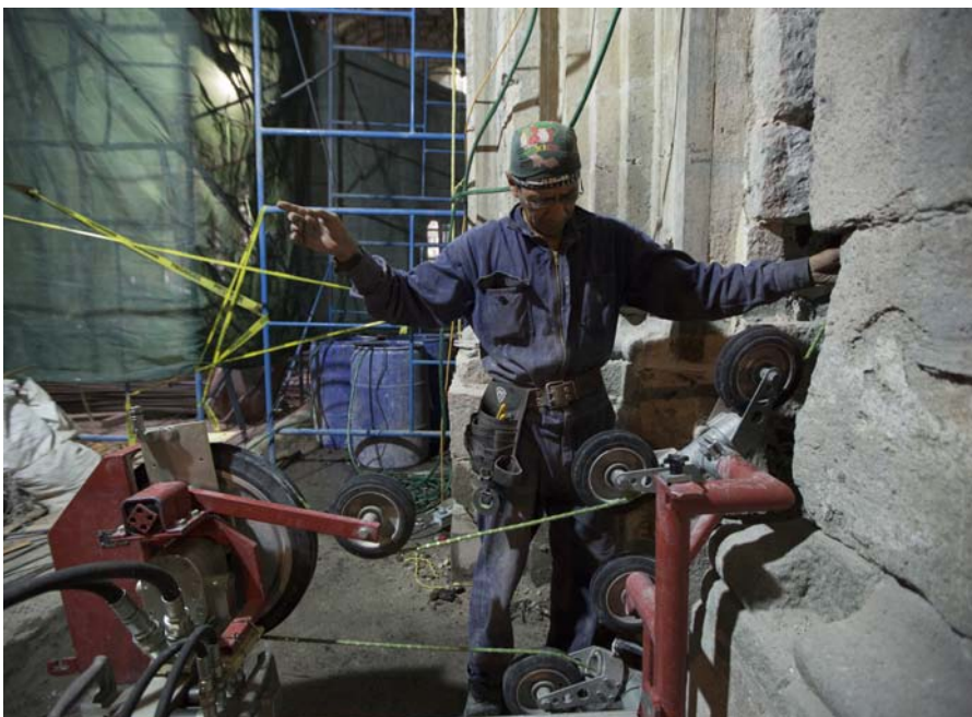
Equipo de corte para abrir una junta de contrucción entre capilla y templo.
