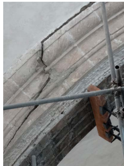
Fracturas y deterioro de mampostería en bóveda y arcos.
