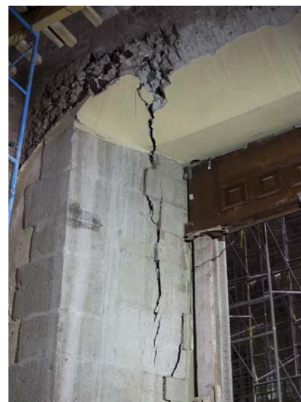
Fracturas y deterioro de mampostería en bóveda y arcos.
