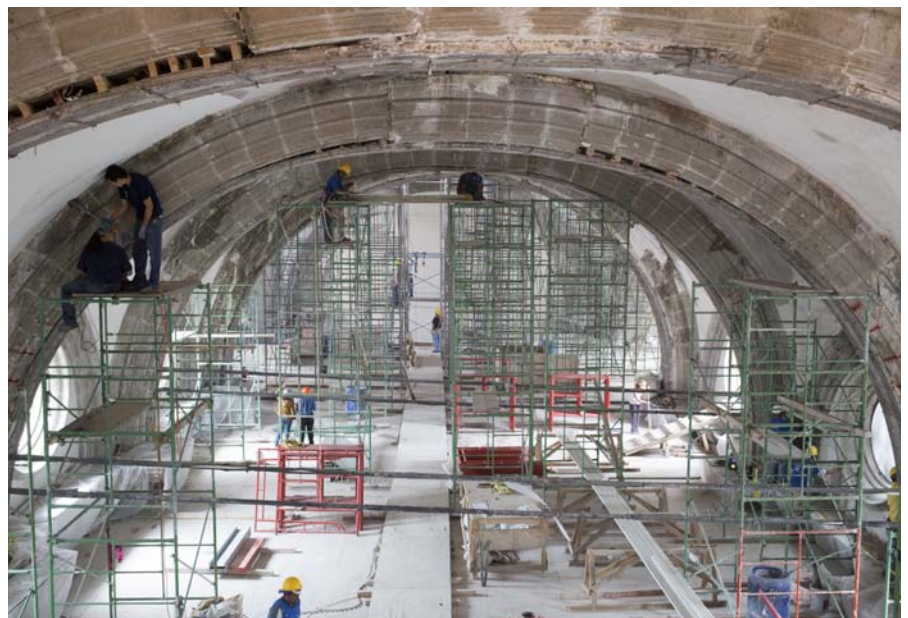
Plataforma de trabajo y andamiaje para la restauración de los arcos y bóveda.
