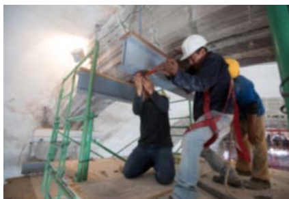
Yugos metálicos para sostén temporal de los arcos y reposición de sillares en dovelas fracturadas.
