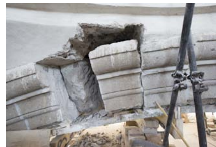
Yugos metálicos para sostén temporal de los arcos y reposición de sillares en dovelas fracturadas.
