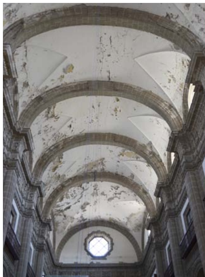
Fracturas y deterioro de mampostería en bóveda y arcos.
